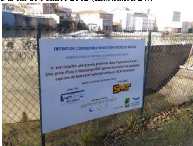
Illustration 24. Travaux à Saverdun fin 2012 (MIGADO ©)
