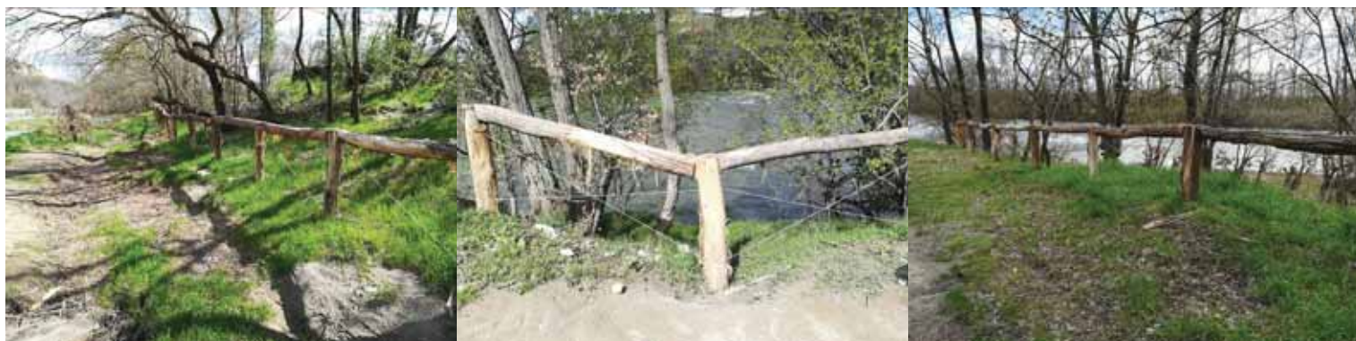
Clôtures en acacia pour fermer certains accès à la ripisylve (MIGADO ©)
