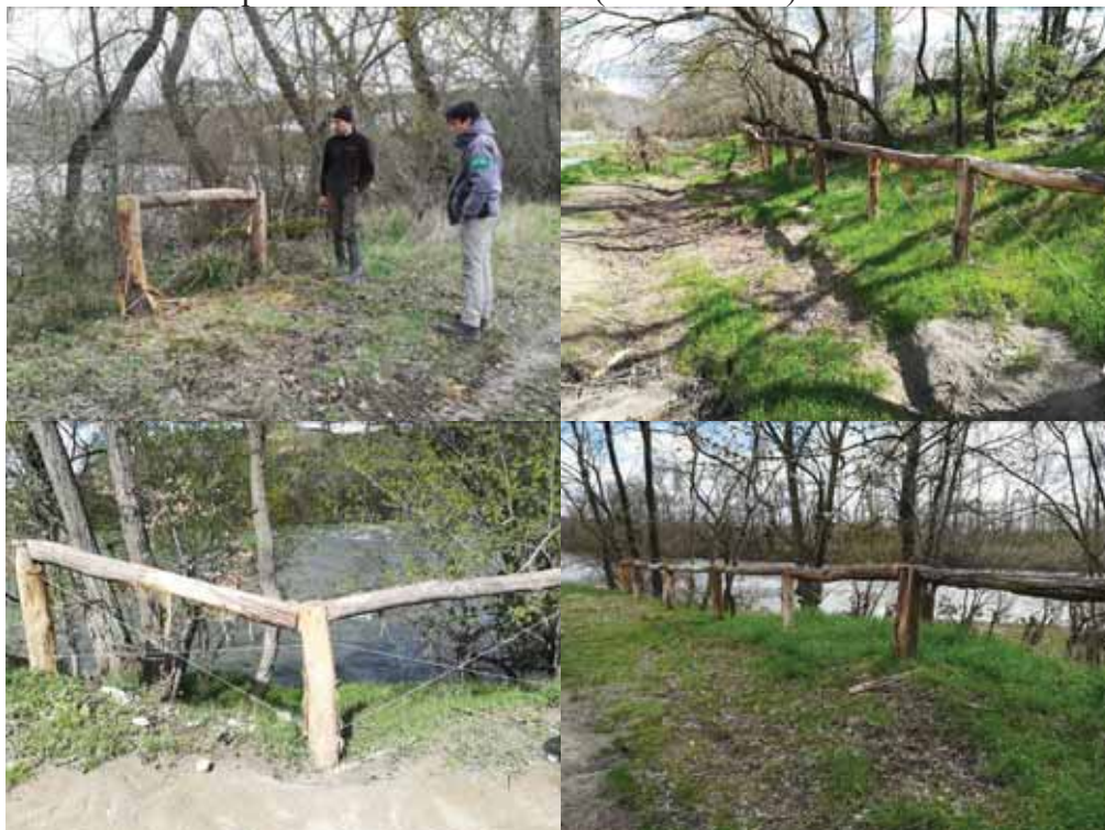
Illustration 5. Chantier de mise en défens et visite de fin de chantier sur la mise en place de barrières sur les ramiers de Clermont-le-Fort (MIGADO ©)
