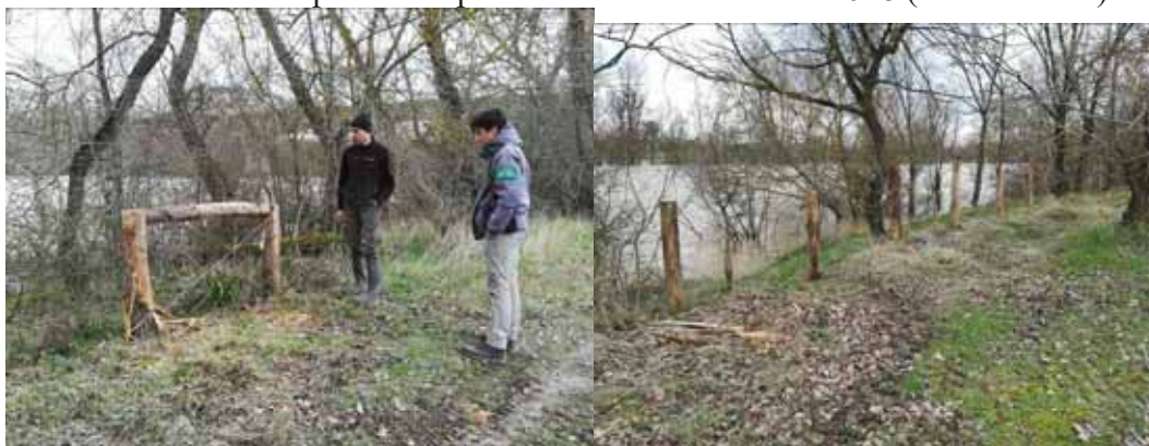
Illustration 2. Travaux en cours (MIGADO ©)
