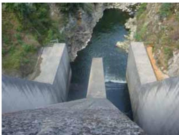
Vue des canaux de décharge à l'aval immédiat des vannes de fond. Ils assurent également la dissipation de l'énergie lors des déversements sur les clapets.
