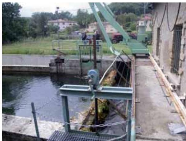
Vue du plan de grille et du dégrilleur (canal en eau)
