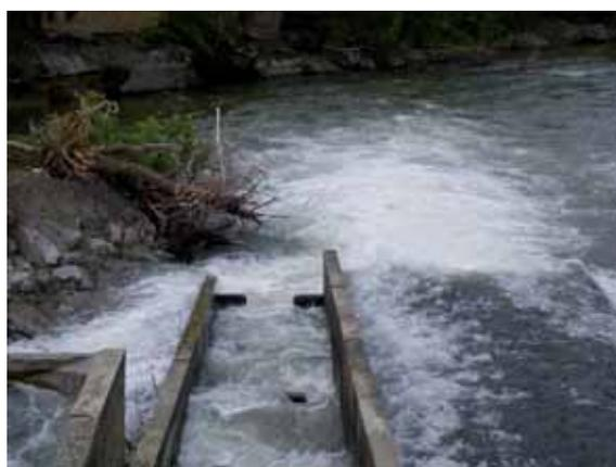
Conditions d'écoulement à environ 1.5 fois le module. On peut voir que la sortie de la passe est peu visible
