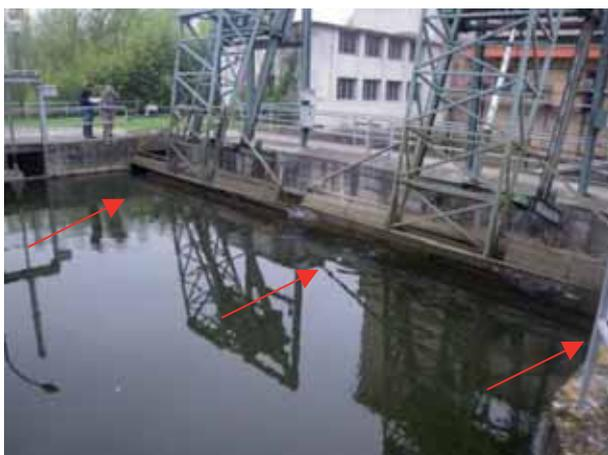
Vue des exutoires de surfaces (indiqués par des flèches) au droit du plan de grille
