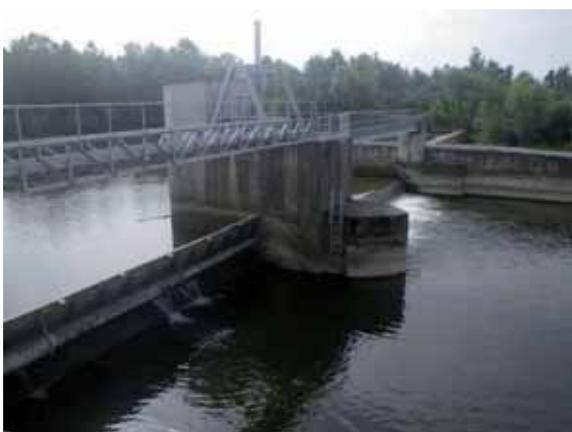
Vue des clapets mobiles du barrage et de la passe à poissons en arrière-plan)
