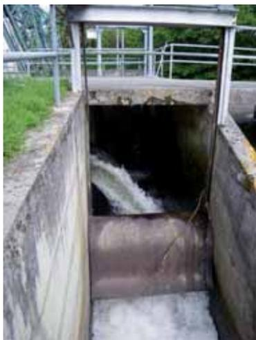
Vanne levante ouverte partiellement (17 mai 2010) et réduisant le tirant d'eau dans le bassin
