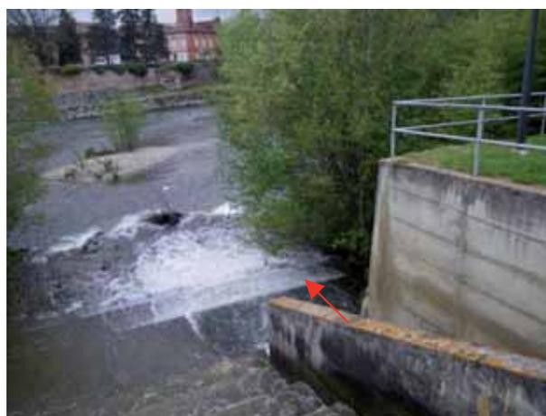
Restitution des poissons au TCC : les poissons circulent sur le béton (voir flèche)
