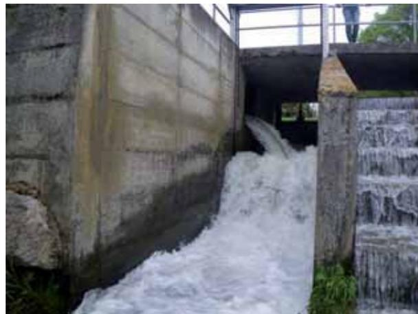
Vanne levante fermée (23 avril 2010) permettant de créer un bassin de réception suffisant
