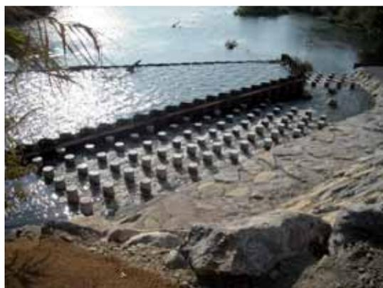
Rampe en enrochements présentant des singularités préfabriquées en béton armé régulièrement réparties (passe de Callet sur le Gardon)
