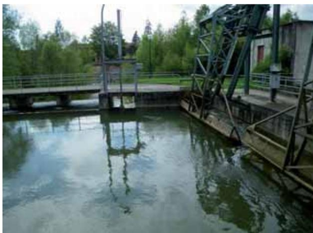
Vue du plan de grille et du dégrilleur (au 1<sup>er</sup> plan). On peut voir également la vanne de décharge et le déversoir de sécurité (au 2<sup>nd</sup> plan)
