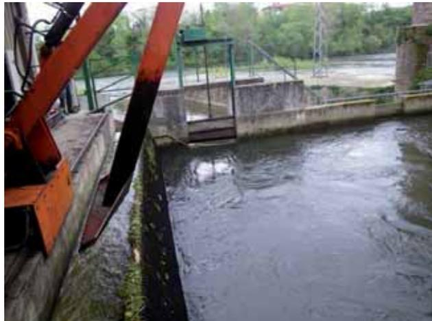
Vue de l'exutoire de dévalaison au niveau de la vanne de décharge du canal d'amenée
