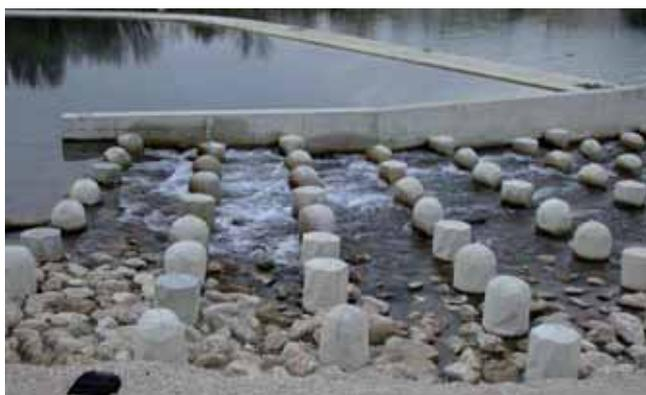
Rampe en enrochements présentant des singularités préfabriquées en béton armé régulièrement réparties (passe de Remoulins sur le Gardon)
