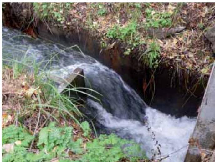
Chute importante au droit de la cloison n°5. Les écoulements dans les bassins aval sont ainsi particulièrement turbulents
