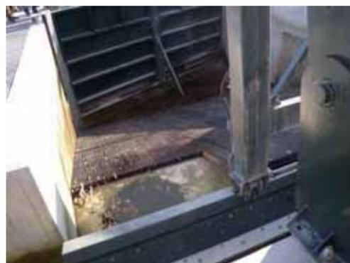
Exemples de plans de grille inclinés longitudinalement (Montfourat sur la Dronne et Masseys sur le Gave de Pau)
