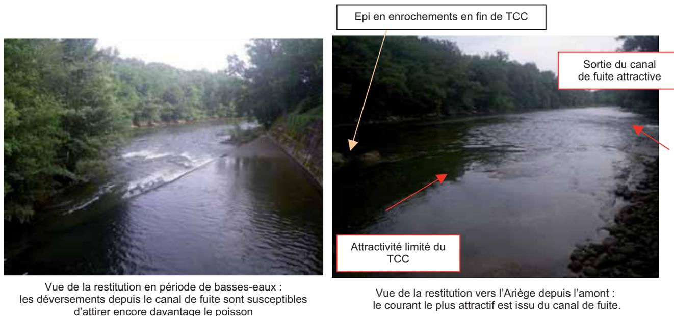
Précisons que des essais ont été menés pour tenter d'améliorer la situation à savoir i) la réduction de la section hydraulique du TCC par l'aménagement d'un épi en fin du TCC dans le but d'augmenter les vitesses, et ii) l'installation d'une barrière électrique dans le canal de fuite pour empêcher la remontée des poissons.
