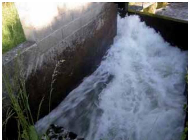
Jet venant percuter la paroi béton au niveau du changement de direction dans
