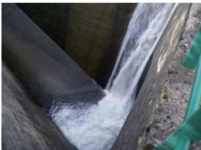
Vue de la chute en sortie de l'exutoire : les poissons peuvent se blesser à la réception ou lors de la chute contre le béton
