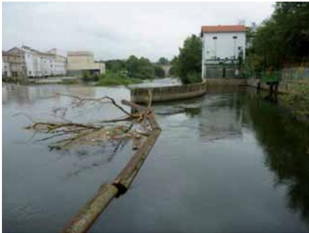
Vue du canal d'amenée à l'usine et protégé par une drome flottante
