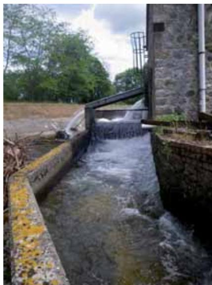
Les poissons engagés dans le canal de dévalaison ne pourront pas rejoindre le canal d'amenée (chutes importantes et tirants d'eau faibles).
