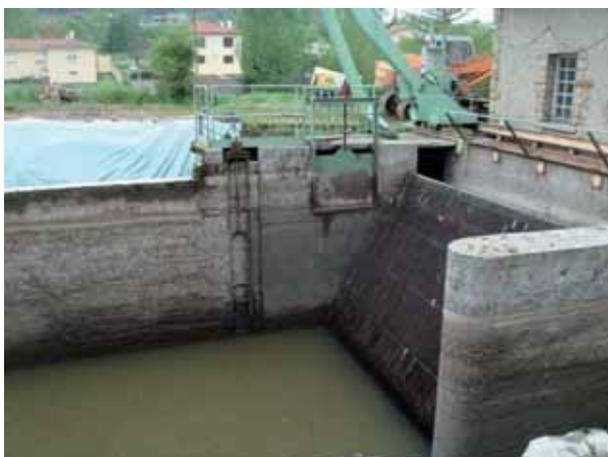
Vue du plan de grille et du dégrilleur à l'usine (canal assec)
