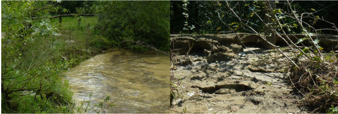
Illustration 22. Crue et décrue de l'Ariège au niveau d'une plage fascinée de Clermont le Fort (Sicoval ©)
