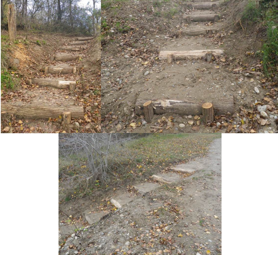
Illustration 15. Gradines en acacias sur le site de Clermont-le-Fort (MIGADO ©)
