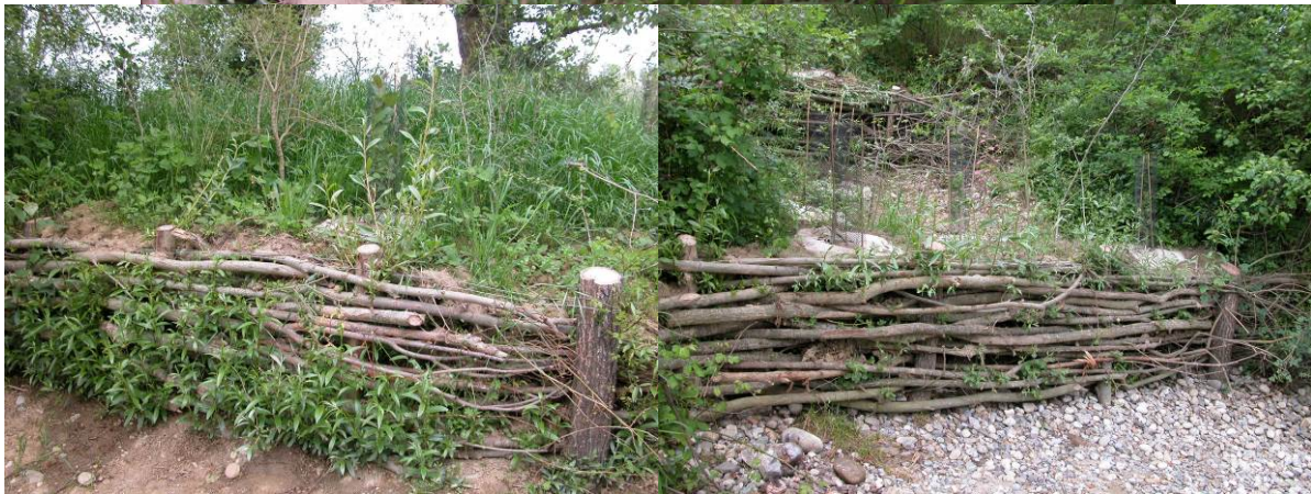
Illustration 21. Fascines créées sur les plages 1, 2 et 3 de Clermont-le-Fort (MIGADO ©)
