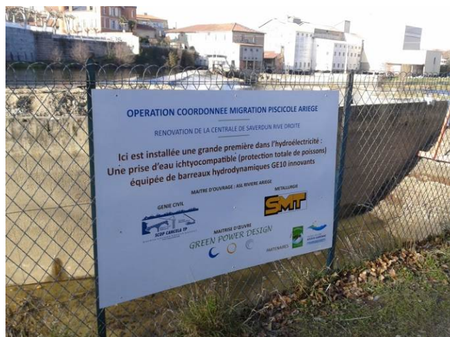
Illustration 31. Travaux à Saverdun fin 2012 (MIGADO ©)
