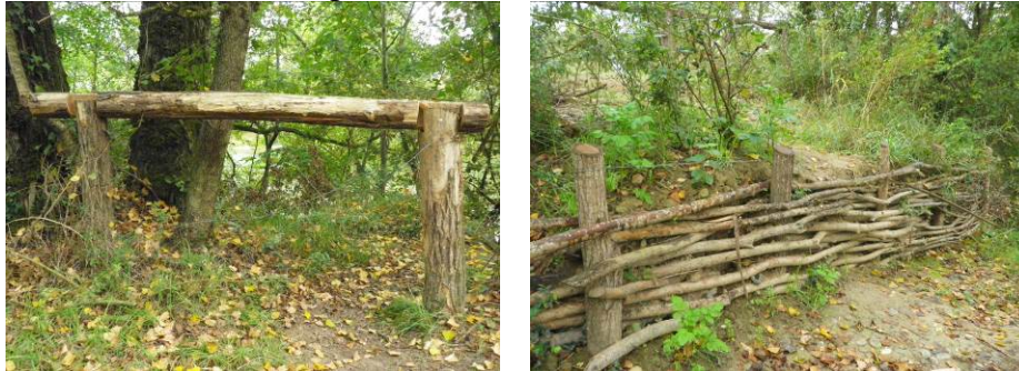
Illustration 19. Dégradations constatées sur les installations (MIGADO ©)
