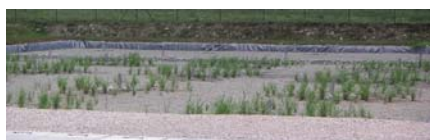
Station de traitement des eaux usées d'Oust et Seix—Filtres plantes de roseaux (MIGADO ©)
