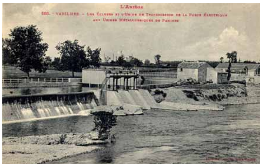
Illustration 5. Ecluses et usine de transmission de la force électrique aux usines métallurgiques de Pamiers
