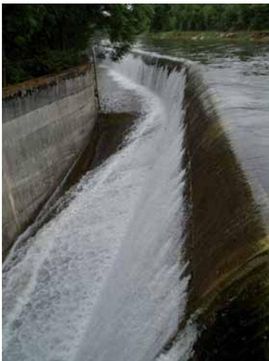
Canal de décharge lors d'un déversement de 25 m<sup>3</sup>/s le 11/06/2008
