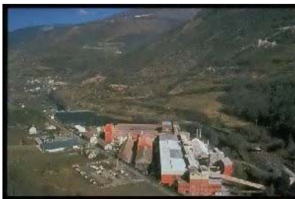
Usine de Beyrède (ALCAN ©)
