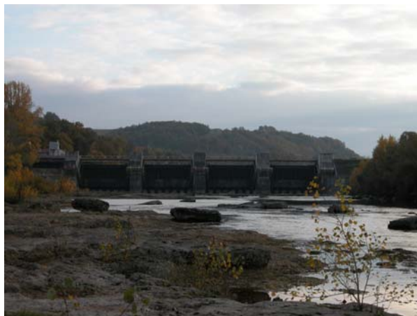
Barrage de Labrioulette (MIGADO ©)
