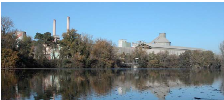
Cimenterie Lafarge (MIGADO ©)
