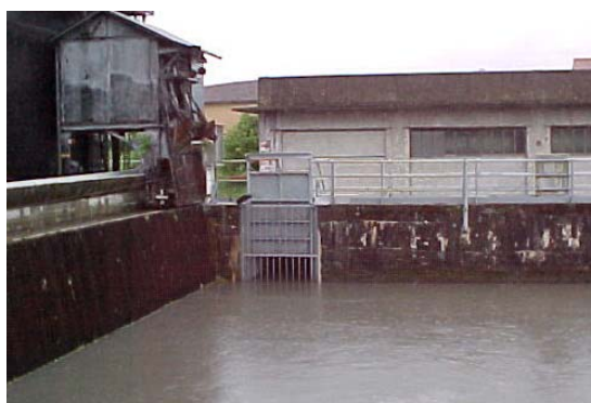
Exutoire de surface de Pointis au niveau du plan de grille de l'usine (MIGADO ©)
